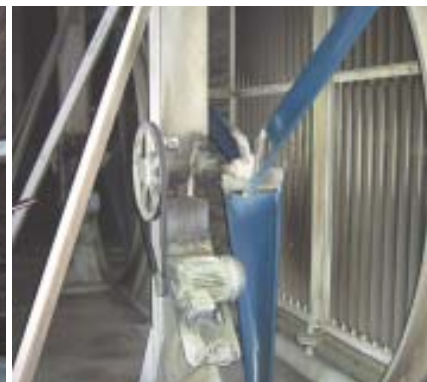
(r.) Ventilatoren in den Trockenkammern. Drehzahlregulierung spart 24% Energie.
