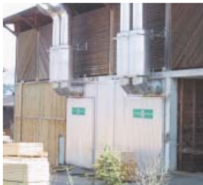
(l.) Die Trockenkammern verbrauchen viel Energie.
